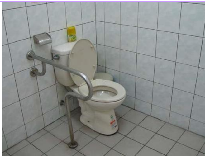
安全的扶手避免跌傷
